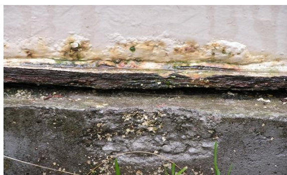
Figura 6. Corrosión por placas o exfoliada, producida por efecto de un agente corrosivo a altas temperaturas, arriba de 500°C (parte externa del crisol). Fuente: Archivos SIE - INDESA, 2019.
