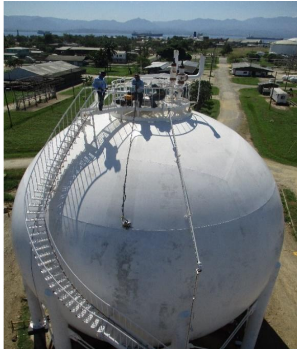
Figura 11. Inspeccion con NAVIC3. Fuente: archivos SIE-INDESA 2019.
