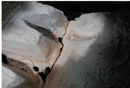
Figura 5. Preparación de la base, zona de reconstrucción lista para iniciar la soldadura. Fuente: Aguilar R. y Soria L. 2011.
