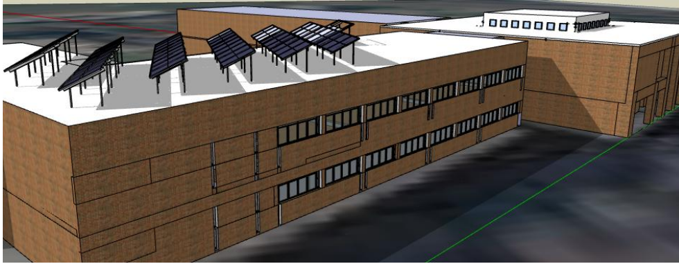
Figura 12 –Distribución de los paneles en la terraza. Fuente: Elaboración Propia.
